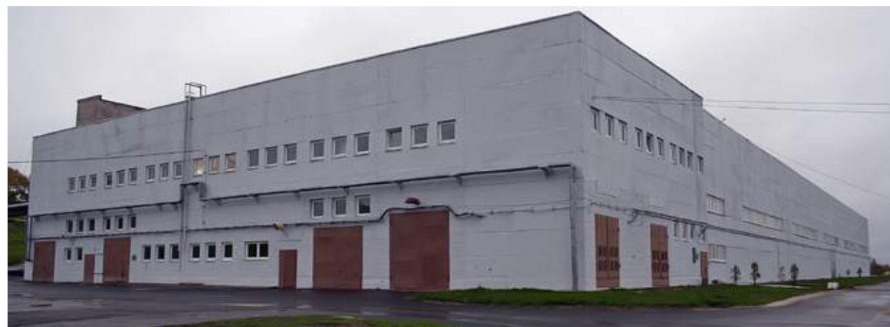
Рисунок 2 Водоочистная станция №3, г. Череповец.
